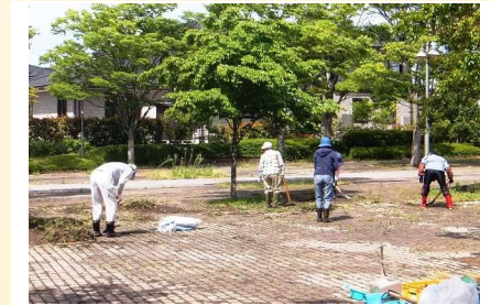
ボードプラザ土壤除去
